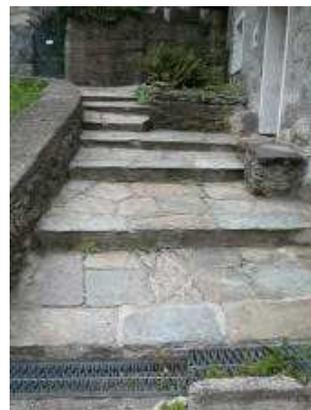
Tali pavimentazioni vanno bene sia per rivestire ampi spazi pianeggianti, sia per percorsi a gradinata (tipo mulattiera). In tal caso si dovrà fare attenzione a realizzare lo spigolo con pietre adeguatamente sagomate, che presentino il bordo arrotondato, e non a spigolo vivo.
