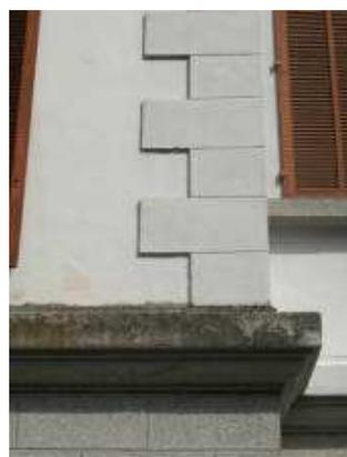
Lo spigolo dell'edificio è sottolineato da bugne angolari eseguite in intonaco in leggero rilievo e con giunto stilato. In questo caso l'ombra non è simulata ma reale e crea lo stacco tra fondo facciata e angolare, che sono quasi della stessa tinta.
