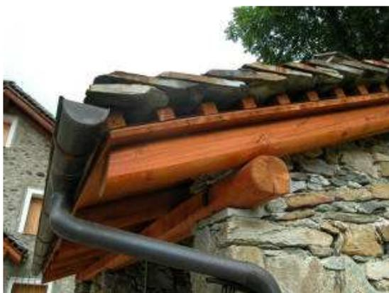
Edificio di carattere rustico, con sporto del tetto realizzato con il prolungamento dei puntoni: schema costruttivo di tetto in beola non isolato, con tavolato interno: trave di banchina a sezione circolare grossolanamente lavorata, travicelli con interasse di circa 60 cm, tavolato di perline maschiate in forte spessore (4-5 cm), strato in materiale impermeabile, listellatura orizzontale, beole di piccole dimensioni, con sormonto di massimo pari a tre elementi.
