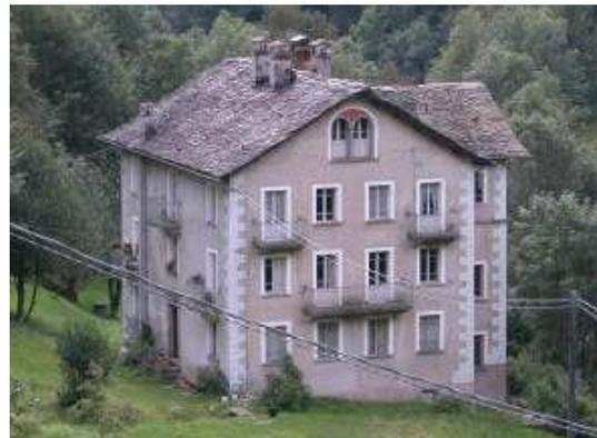
Caratteristica delle aperture delle case di Fobello è quella di avere il serramento posto in posizione molto arretrata rispetto al filo esterno della facciata, probabilmente per l'esigenza di proteggere gli infissi, vista la ridotta dimensione degli sporti del tetto e la notevole altezza degli edifici.
