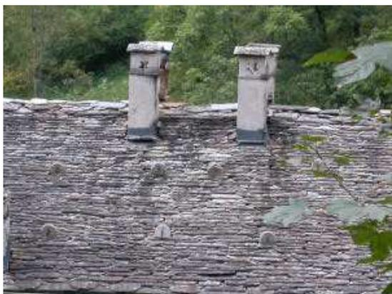
Tetto tradizionale, che non ha subito interventi recenti; le falde sono state realizzate con beole locali di media e soprattutto piccola pezzatura, mentre gli elementi di dimensioni maggiori sono stati riservati a coprire il colmo e terminare la falda lungo la gronda.
