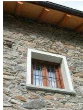
Soluzione tipologica non tradizionale: gli infissi di oscuramento, in legno, sono ospitati entro allo spessore del muro, applicati al telaio del serramento anziché fissati con cardini sul muro esterno.
