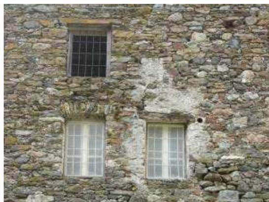
Ottimo effetto per un muro esterno in pietra a vista. Il materiale, certamente originale o di recupero, è perfettamente armonizzato per tipo, colore e pezzatura mista; i giunti di malta di calce risultano arretrati rispetto al filo esterno delle pietre. Difficile riconoscere se trattasi di muro originale o frutto di un perfetto e sensibile rifacimento.
