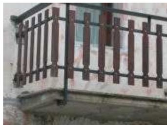
Soletta in c.a. e parapetto in ferro e legno, d'ecuzione tecnica corretta (profili del gocciolatoio, posizione dell'ancoraggio della ringhiera, ecc.), ma di discutibile risultato estetico e non conforme alla tradizione locale e pertanto non accettabile
