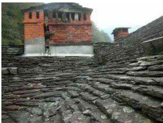
Risulta pertanto ovvio che, impiegando materiali tagliati artificialmente, con dimensioni costanti e formati regolari, con superficie pulita e regolare, l'effetto che si ottiene è ben diverso da quello visibile sui tetti tradizionali.
