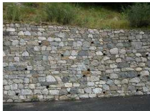
soluzioni con muro in pietrame che fa corpo unico con il retrostante muro in cls armato:**accettabili**
