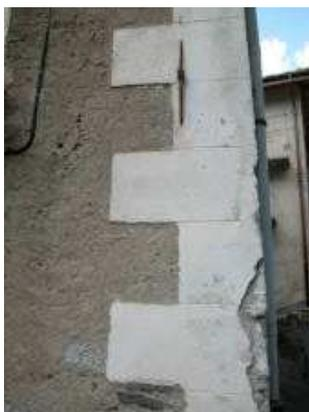
Semplice bugnato angolare, in intonaco tipo marmorino, eseguito con calce e inerti finissimi, con finitura lisciata. Il colore bianco crea contrasto con la facciata in intonaco di calce e sabbia mescolata con terra non tinteggiato. Le bugne angolari sono suggerite mediante giunti appena sottolineati da una sottile incisione.
