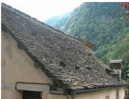
Il manto in beole, non essendo vincolato da misure fisse e interassi precisi, consente all'artigiano esperto di realizzare curvature, impluvi, displuvi, raccordi, cambi di pendenze solo con l'abilità della lavorazione della posa degli elementi. L'ossidazione della pietra con il tempo, la crescita di muschi e licheni, qualche colata di ruggine proveniente dai supporti in ferro dei paraneve, attribuiscono al manto un particolare e inconfondibile aspetto.
