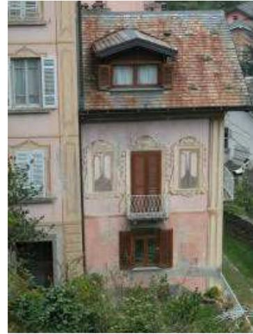
Purtroppo i decori originali risultino spesso molto degradati e sbiaditi, quando non addirittura danneggiati da successive tinteggiatura, o da interventi di trasformazione, condotti con imperizia e senza la dovuta sensibilità.
