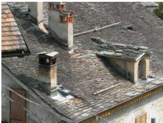
Interventi recenti hanno completamente stravolto la funzione e, conseguentemente, la tipologia dell'abbaino: con il recupero dei sottotetti a funzioni abitative l'abbaino viene adottato per garantire l'illuminazione e la ventilazione dei vani del sottotetto e pertanto assume dimensioni notevolmente maggiori e si colloca in posizioni funzionali alla distribuzione interna, e in numero tale da poter fornire luce ed aria ad ogni ambiente.
